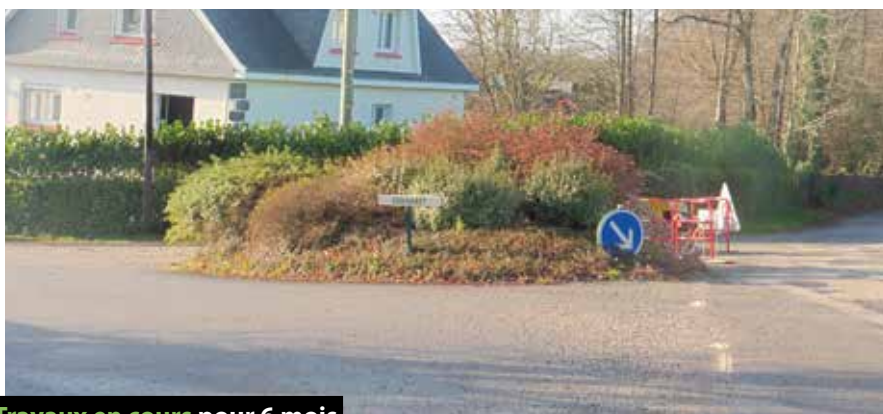
Travaux en cours pour 6 mois
