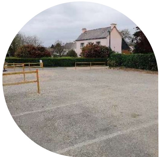
Mise en place d'un nouveau parking après la suppression de la maison Beuzet
