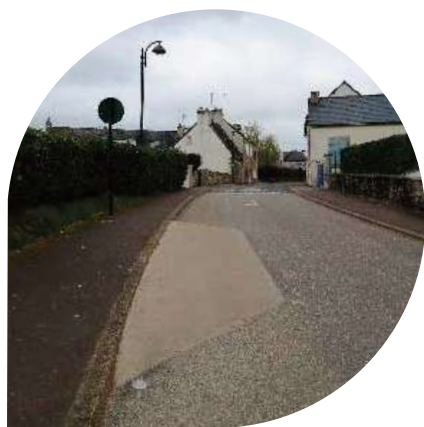
Rénovation de la rue du Croeziou...
