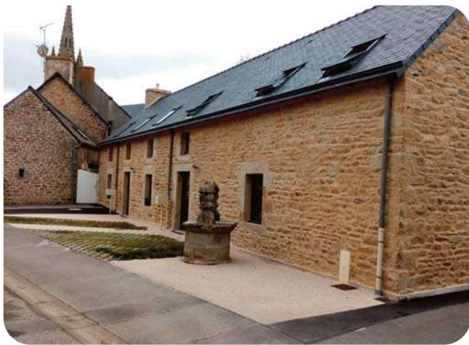
Rénovation de 2 logements locatifs
